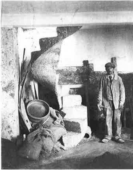
Bild 3 Einfachheit: Spindeltrappe in Eisenbeton, Francois Hennebique, um 1900.
