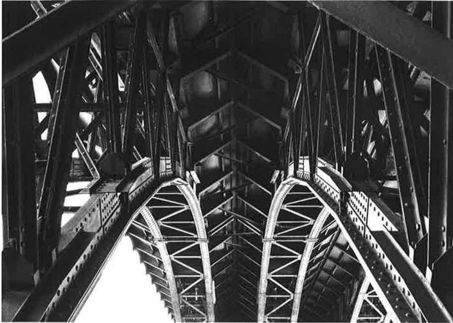
Bild 5 Mut zur Verantwortung: Chemnitztalviadukt, errichtet 1905, aktuell vom Abriss bedroht
