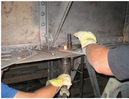
*Bild 12. Reparatur am Verbandsanschluss durch Nietung, 2012*
