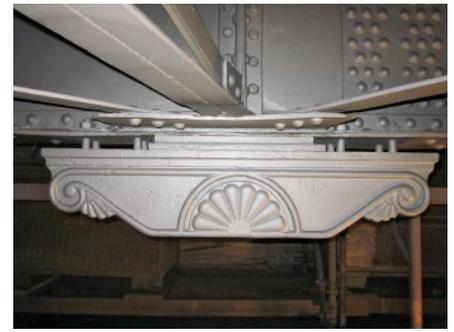
*Bild 16. Überbau mit angeschlossenem Kapitell vor Aufsetzen auf die Stütze, Farbgebung nach historischem Befund*
