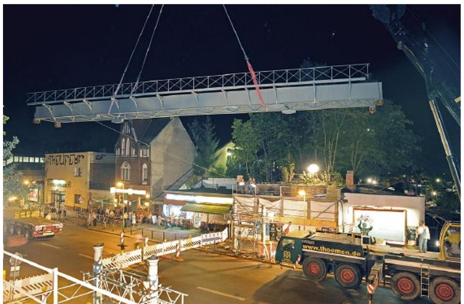
*Bild 15. Einschwenken des instandgesetzten Überbaus im August 2012*
