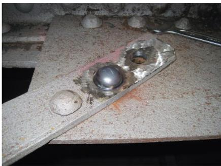
*Bild 13. Neuer Niet am Verbandsanschluss*
