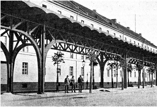
**Bild 8.** Rohbau des Viadukts ohne Geländer in der Gitschiner Straße, 1897 ([1], 1897)
