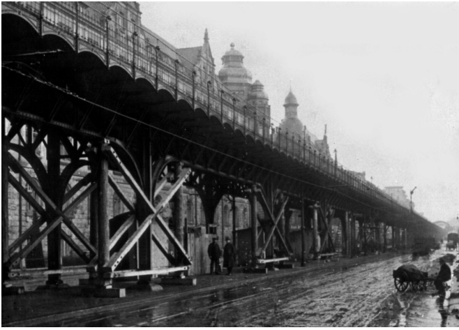
Bild 5. Provisorische Sicherung des Viaduktes in der Gitschiner Straße, um 1920 (Landesbildstelle Berlin)
