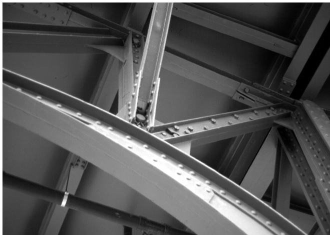
Bild 12. Bolzengelenke im Fachwerk
