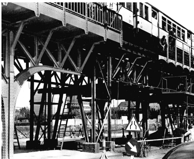
Bild 4. Einbau einer neuen Fahrbahn in der Oberbaumstraße, 1961
