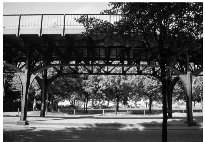
Bild 1. Fachwerkkonstruktion der Linie 1, Oberbaumstraße, 1999 Fig. 1. Frame truss of the viaduct of Line No. 1, Oberbaumstraße, 1999
