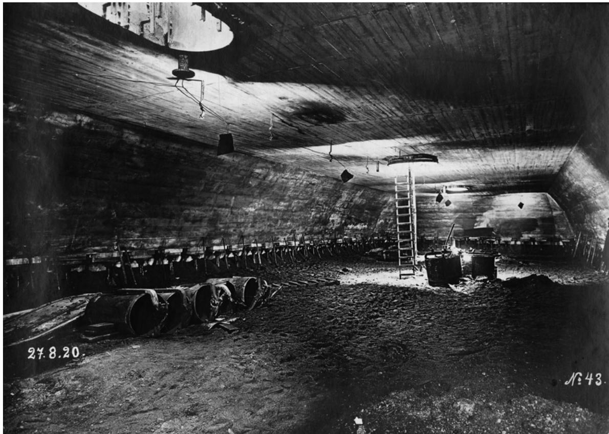
**Bild 6:** Blick in einen Caisson der Sternbrücke Magdeburg, 1920 [72]
