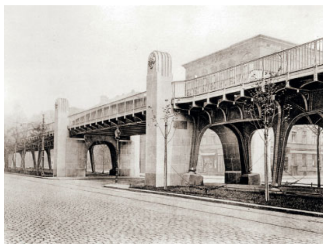
Bild 1. Ansicht des Viadukts, schwere Sandsteinpfeiler markieren die Straßenquerungen (1. Bauabschnitt 1909–13, Aufnahme vor 1920 [1])
