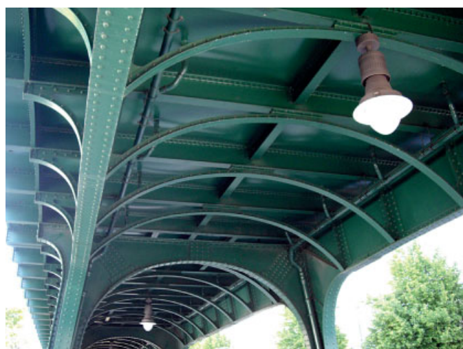
Bild 9. Saniertes Viadukt mit erneuerten Fahrbahnblechen (Aufnahme Lorenz & Co. Bauingenieure) Fig. 9. Overhauled viaduct with renewed track plates
