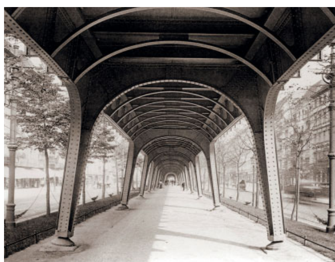
Bild 2. Untersicht des Viadukts mit alternierenden Kragrahmen und Einhängeträgern (1. Bauabschnitt 1909–13, Aufnahme vor 1920 [1])
