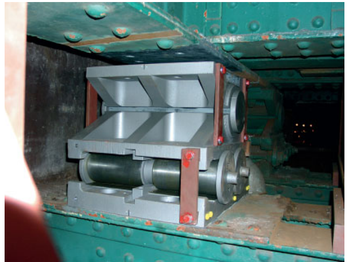
Bild 13. Erneuerter Lagerkörper vor Absenken des Überbaus (Aufnahme Lorenz & Co. Bauingenieure) Fig. 13. Totally renewed bearing support before lowering the superstructure
