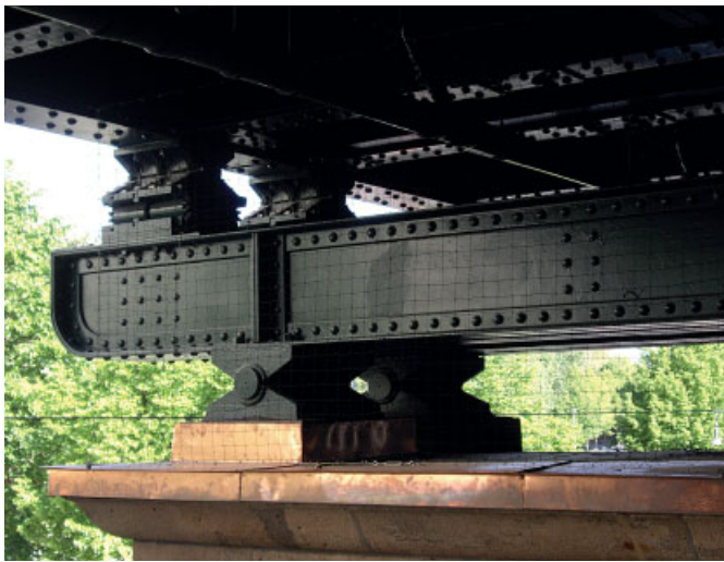
Bild 14. Sanierte Lagerkörper unterhalb des Bahnhofs Eberswalder Straße (Aufnahme Lorenz & Co. Bauingenieure) Fig. 14. Overhauled bearing supports beneath station 'Eberswalder Straße'
