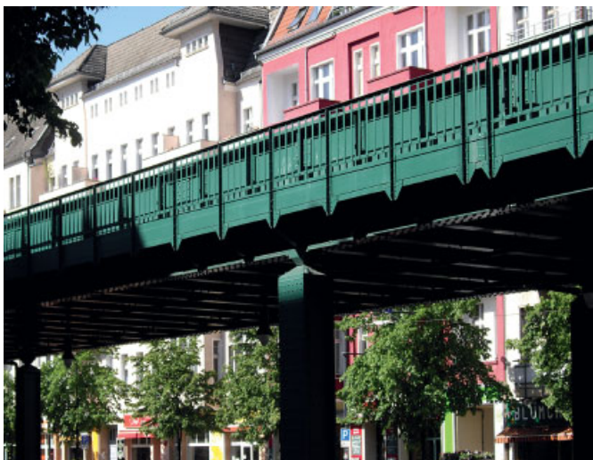
Bild 15. Viadukt im 2. Bauabschnitt (1927–30) nach der Sanierung (Aufnahme Lorenz & Co. Bauingenieure) Fig. 15. Viaduct (2 nd stage 1927–1930) after overhaul
