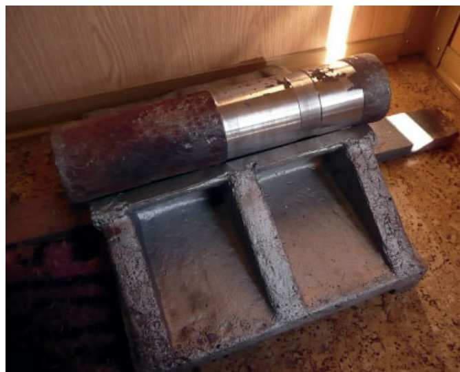
Bild 11. Ausgebauter Lagerkörper, partiell abgegriffener Zapfen mit Rostnarben und Lunkern (Aufnahme Lorenz & Co. Bauingenieure)
