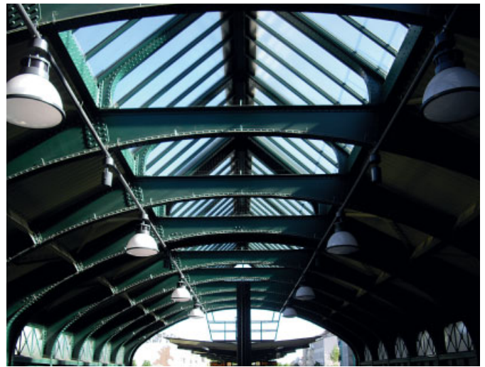
Bild 16. Hallenrahmen im Bahnhof Eberswalder Straße nach der Sanierung (Aufnahme Lorenz & Co. Bauingenieure) Fig. 16. Frameworks in the station 'Eberswalder Straße' after overhaul
